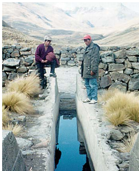
Baño anti-sármico refaccionado por AIGACAA.
